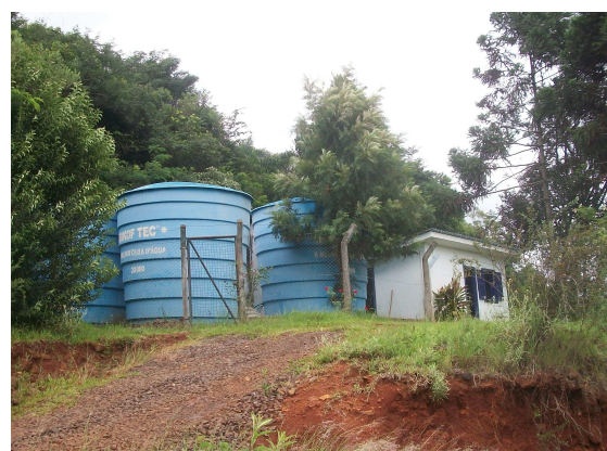
Reservatório de água
