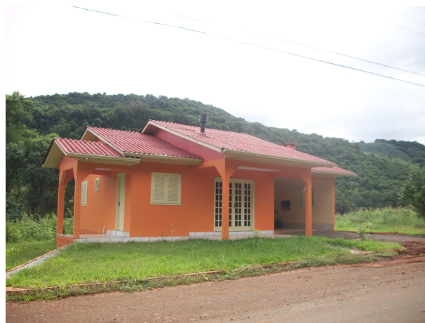
Habitação Alvenaria Padrão Médio
