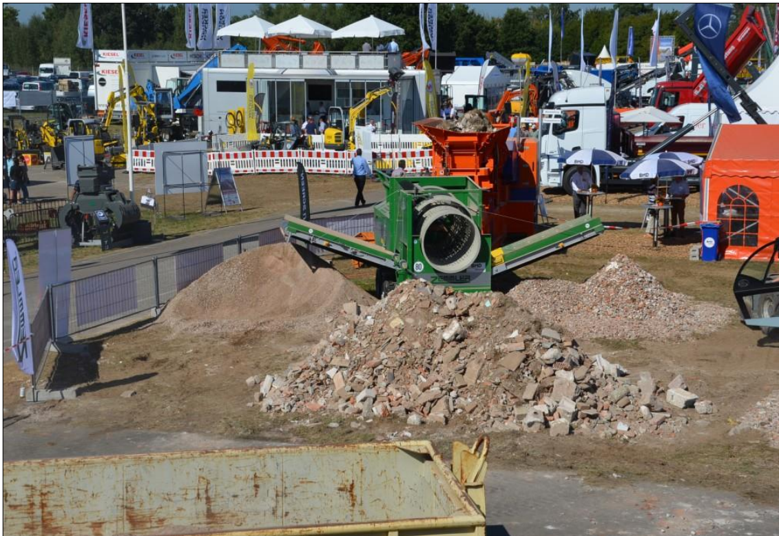
Figura 17 - Tecnologia móvel para tratamento e reaproveitamento dos resíduos da construção e demolição civil RCD
