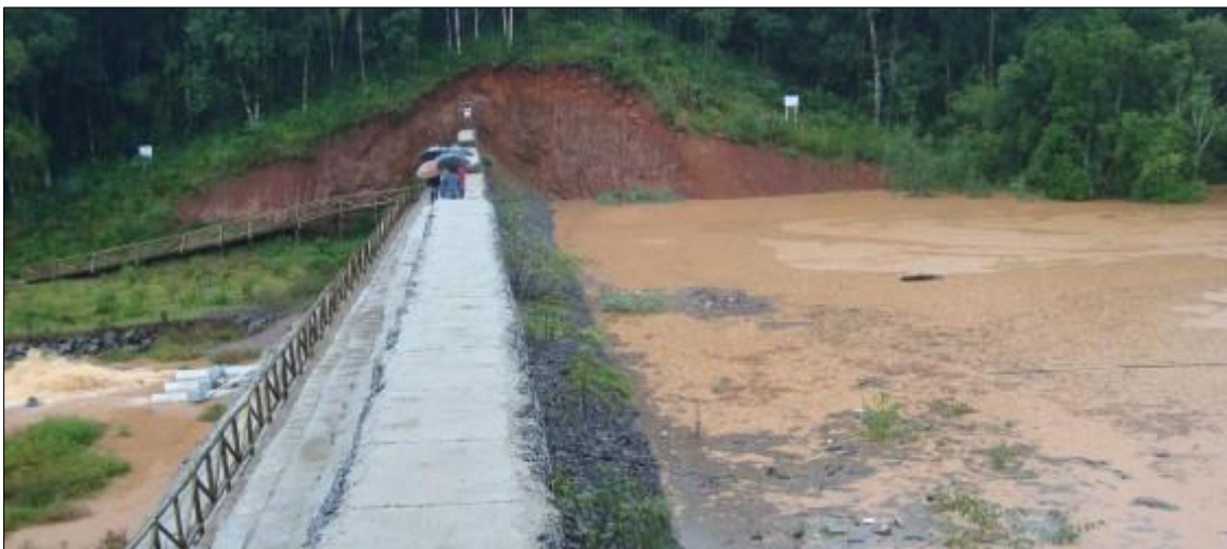
Figura 18 - Barragem de contenção de cheias de Concórdia (Em operação)
