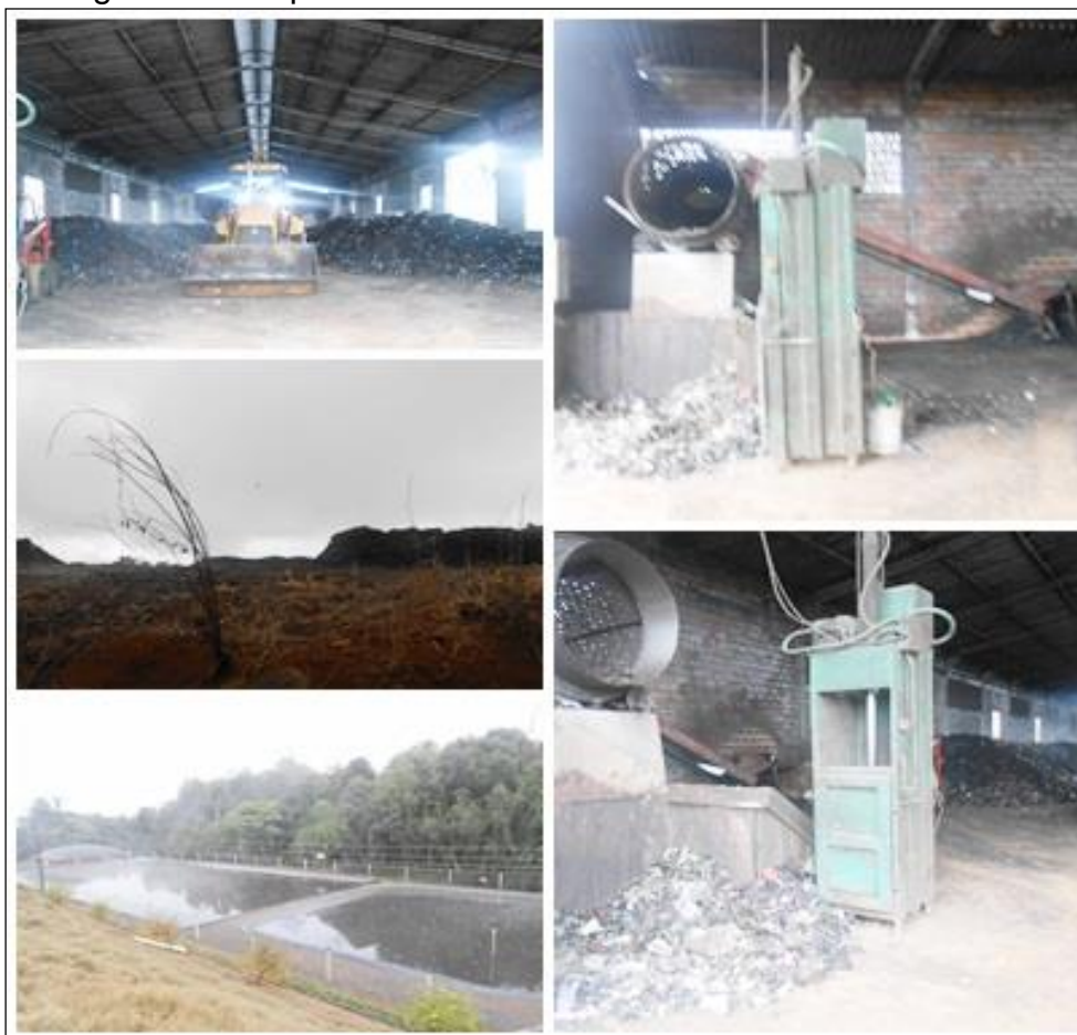
Figura 83 - Dependências do Aterro Sanitário da RONESTRAN
