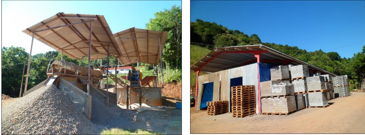
Figura 43 – Britador e Fábrica de blocos de concreto e pavers respectivamente
