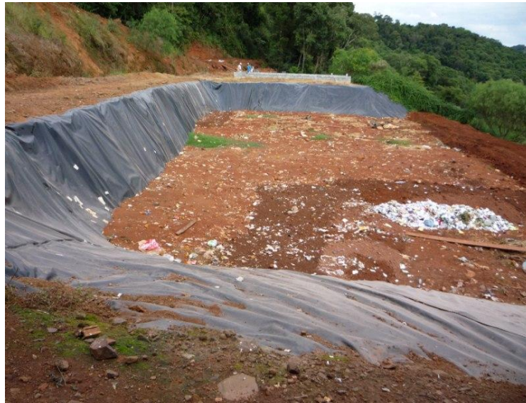
Foto 27 – Vista da camada compactada
