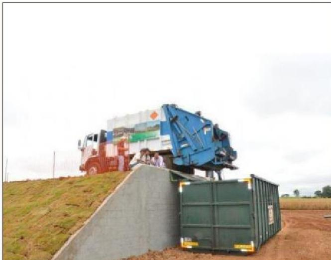
Figura 12. Estação de transbordo – realizada direto no veículo transportador.
