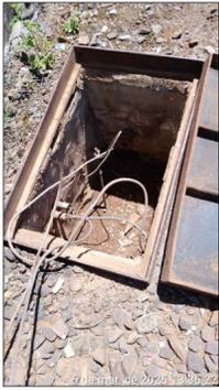
A partir do poste padrão, o ramal de carga deverá ser subterrâneo, atendendo às especificações correspondentes da Norma N 321.0001 Celesc, sendo que poderá ser utilizada a caixa de passagem enterrada existente
